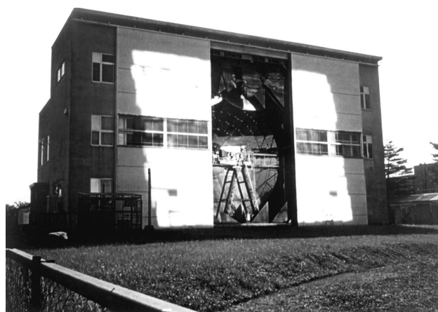
図 6.6 直径 10 m 高精度回転放物面集光鏡 (181 枚のセグメント鏡から構成)
