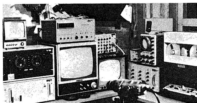
第13図 CT-2のリモート駆動部および赤外テレビ式自動追跡装置
