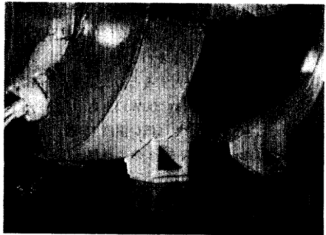
図 5.16 航技研低温風洞断熱工事後の断熱層外部に付いた霜
