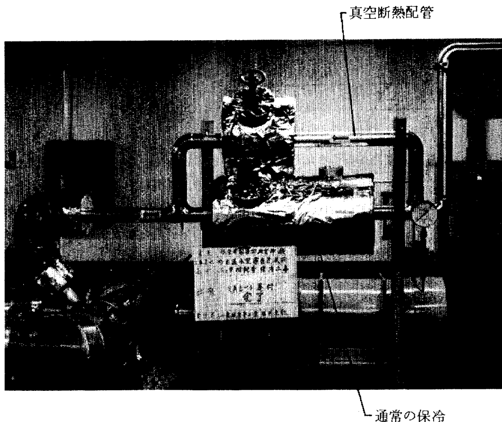
図 5.10 真空断熱配管
