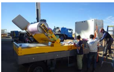
図3. 跳ね上げローラー台車構築
