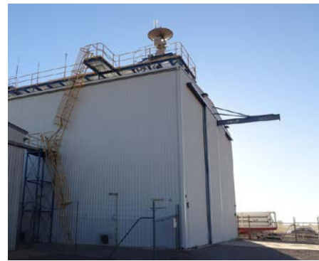
図3: ハンガー屋上に取り付けたアンテナ
