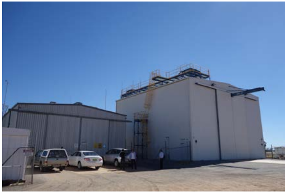
図 1: BLS 施設。左が UNSW, 右が NASA 設置のハンガー。NASA ハンガーではクレーンレールが屋外に突き出し、ペイロードの取扱いを容易にしている。
