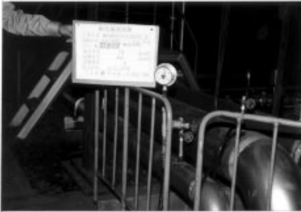
図 16 配管の耐圧試験立会い
