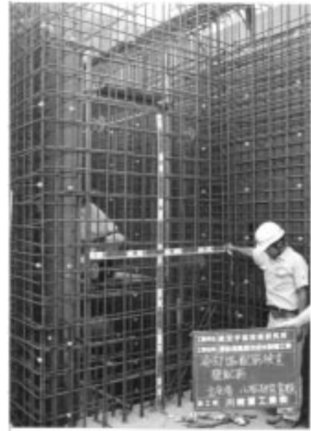
図 11 鉄筋の配筋検査立会い
