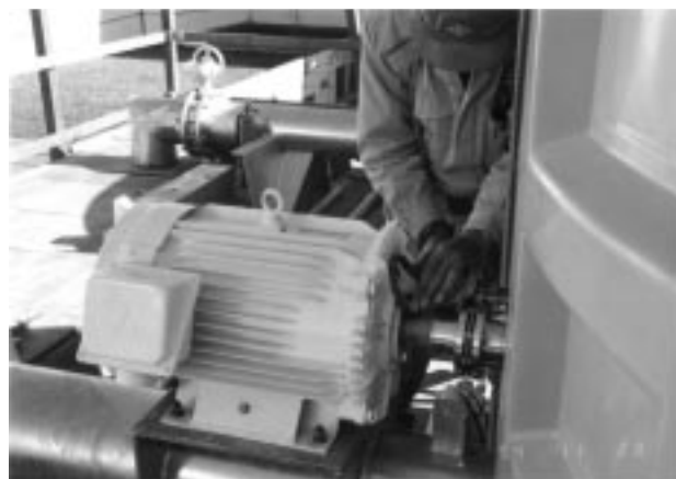
図15 カップリングのセンタリング立会い
