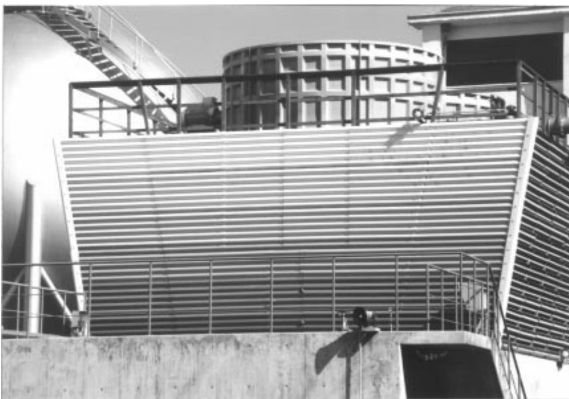
図10 青紫色の6段階グラデーション塗装を施した冷却塔西面
