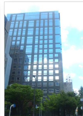
大阪市淀川区西中島 新大阪プライムタワー
