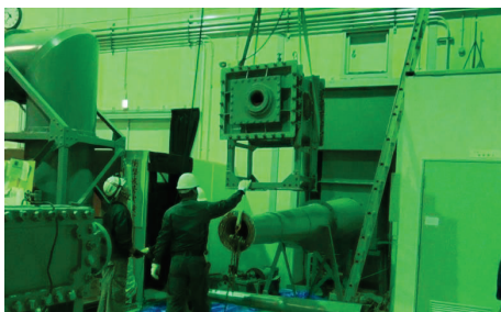
旧 測定部の搬出
