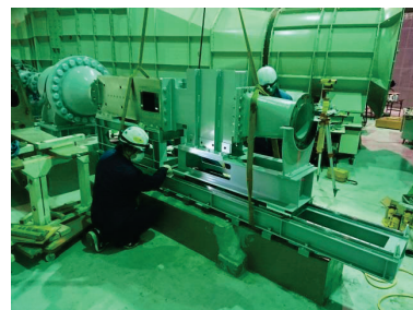
新 測定部の据え付け
