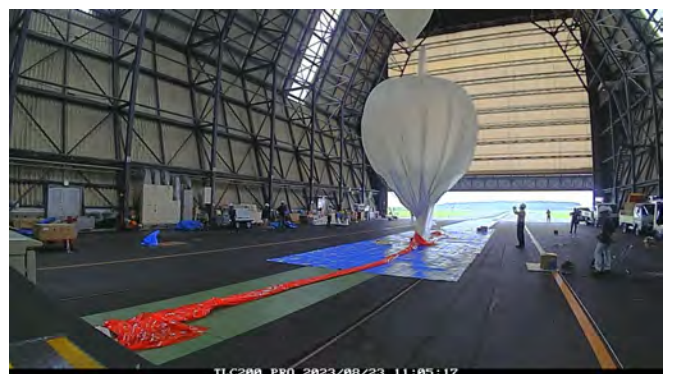
図 7: ガス注入完了。撤収開始。
