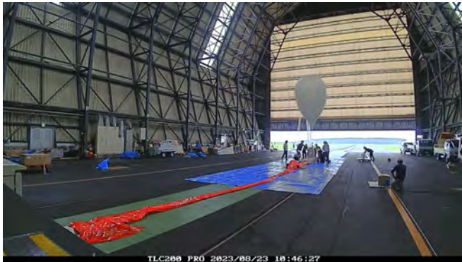
図 2: 気球頭部へのゴム気球のとりつけ。
