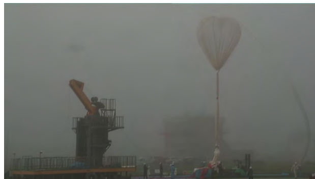
b) 頭部の立てあげ完了。
