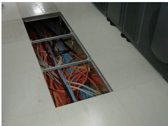
図 3.9 CeNSS の床下内の結合ネットワークケーブル
