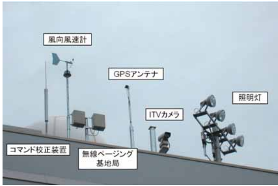
図 26(a) アンテナなどが並ぶ棟屋屋上
