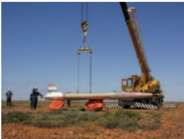
図5.3.1-11 クレーン作業
