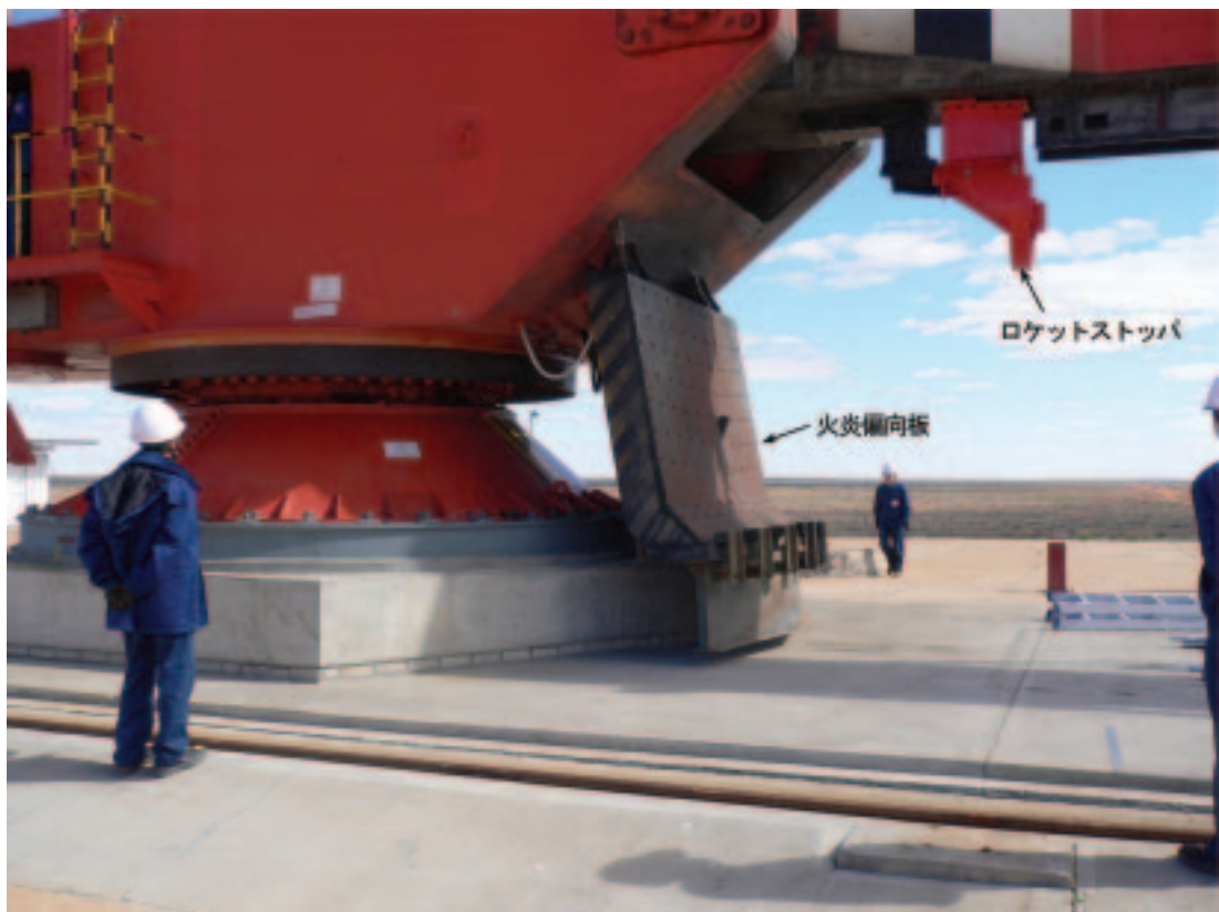
図3.5.1-2 改修後のロケットストップ
