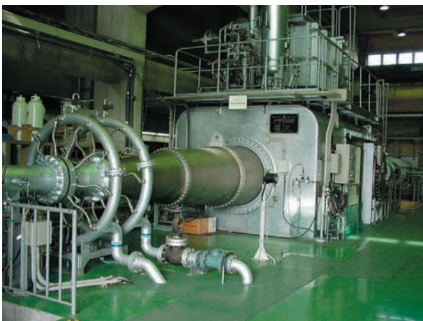
図 3-2 1.27m 極超音速風洞 外観
