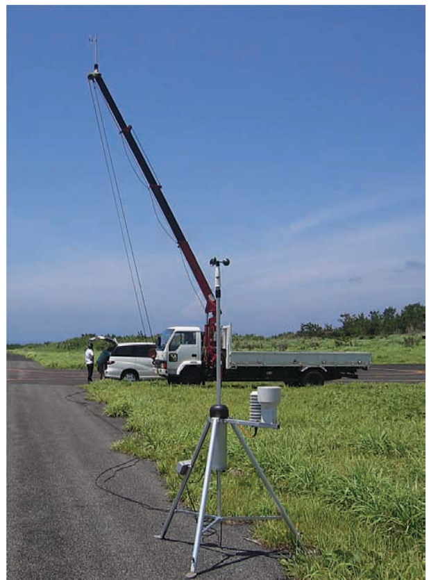
図 5.3.1-2 アンテナ設置状況 (手前は AWS)
