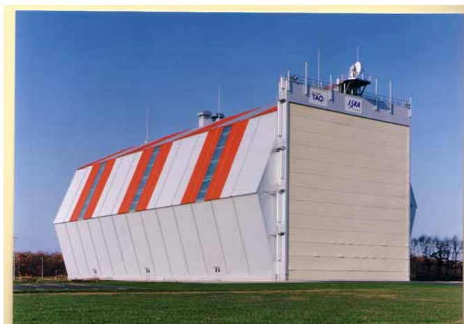
図 A4.2-5 格納庫南西面
