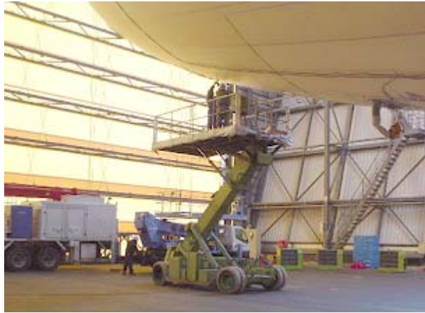
Zリフトによるマーキング確認
