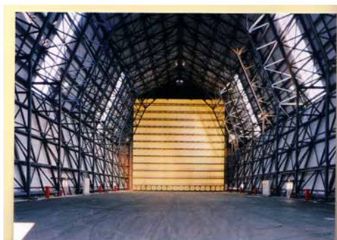
図 A4.2-7 格納庫東向き内部
