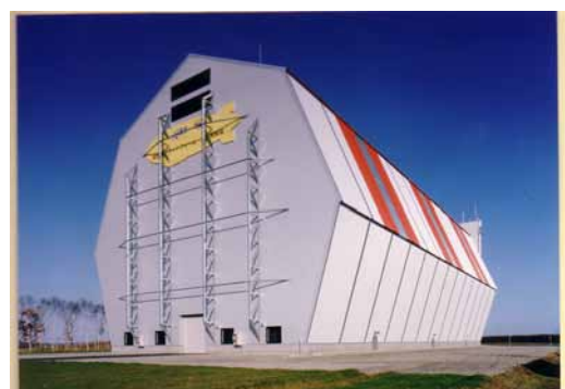
図 A4.2-6 格納庫南東面
