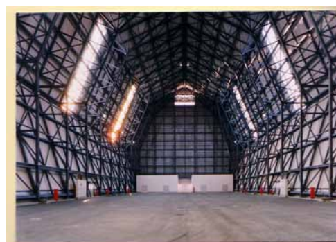
図 A4.2-8 格納庫西向き内部
