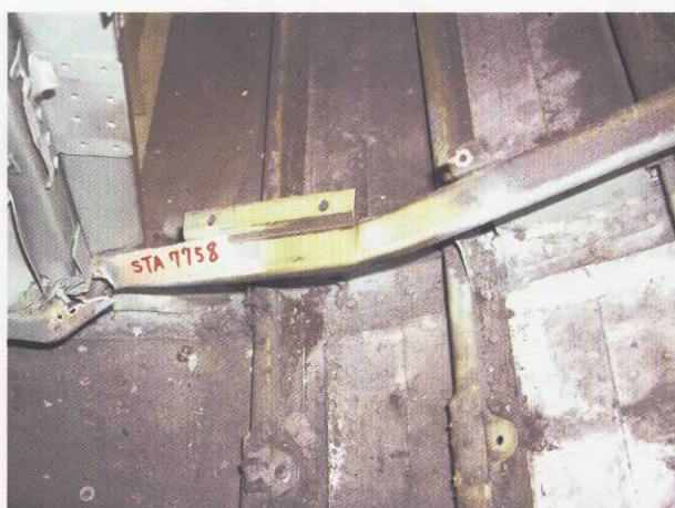
図31. FSTA-7758荷物室左フレームの座屈状況 (前方より)
