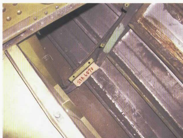
図34. FSTA-6870荷物室左フレームの座屈状況 (前方より)
