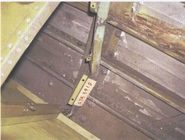
図36. FSTA-5910荷物室左フレームの座屈状況(前方より)
