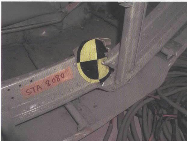
図42. FSTA-8080フレーム左下の座屈状況(前方より)
