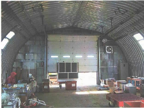
図2 第2廃棄物保管庫の内部
