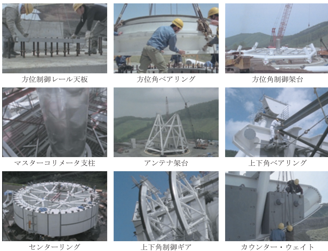
図 16. アンテナ構成要素の組み付け
