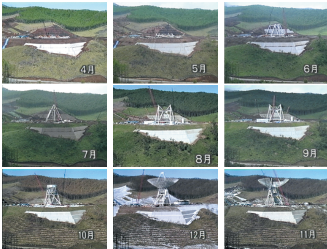
図 15. アンテナ本体建設の進行
