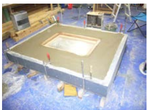
(f) 開口を木枠で残しながらコンクリートを流し込む
