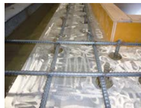
(e) 穴を通過する鉄筋とコンクリート
