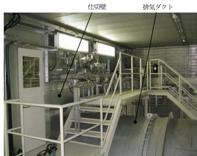
図 31 付帯設備配管類 (仕切壁裏 全景)
