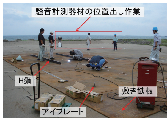
図4.2-4 運転場の設置作業
