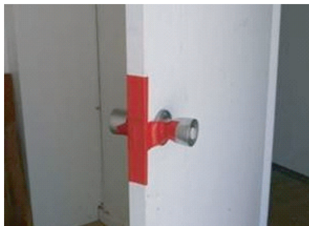
図6.2-11 ドア・ラッチボルトの処置
