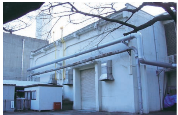
図5 航空推進2号館
