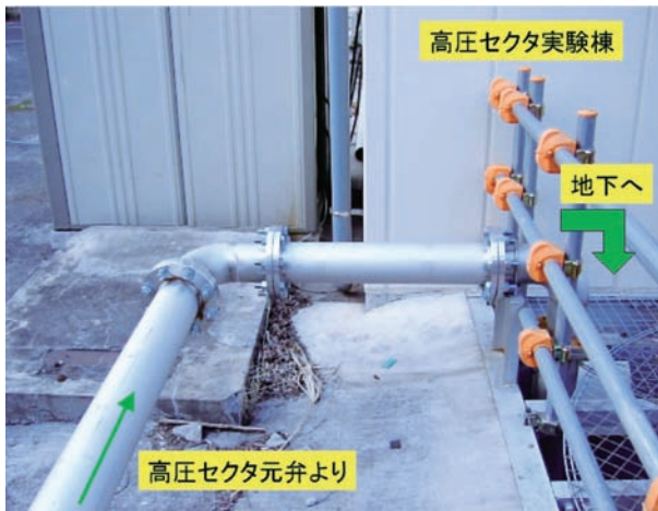
図7 高圧セクタ実験棟及び実験棟への配管導入
