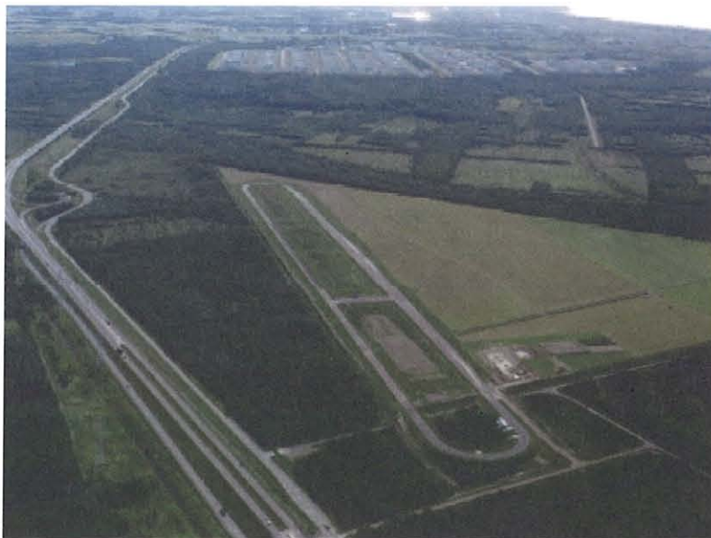
Fig.4-10 苫小牧寒地試験道路全景
