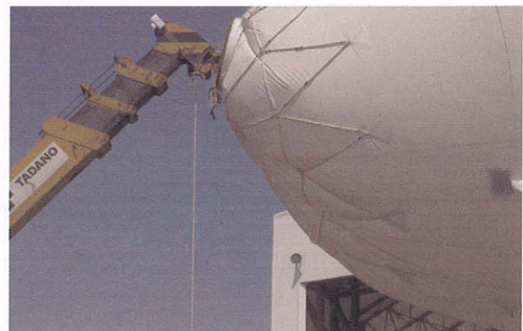
図 3.2-3 船尾端の支持状況
