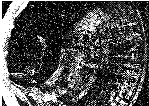
第 5 図 噴射孔付近の FRP 侵蝕状況
