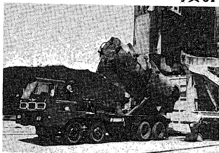
写真35 M-10 モータ組立 (モータの反転)
