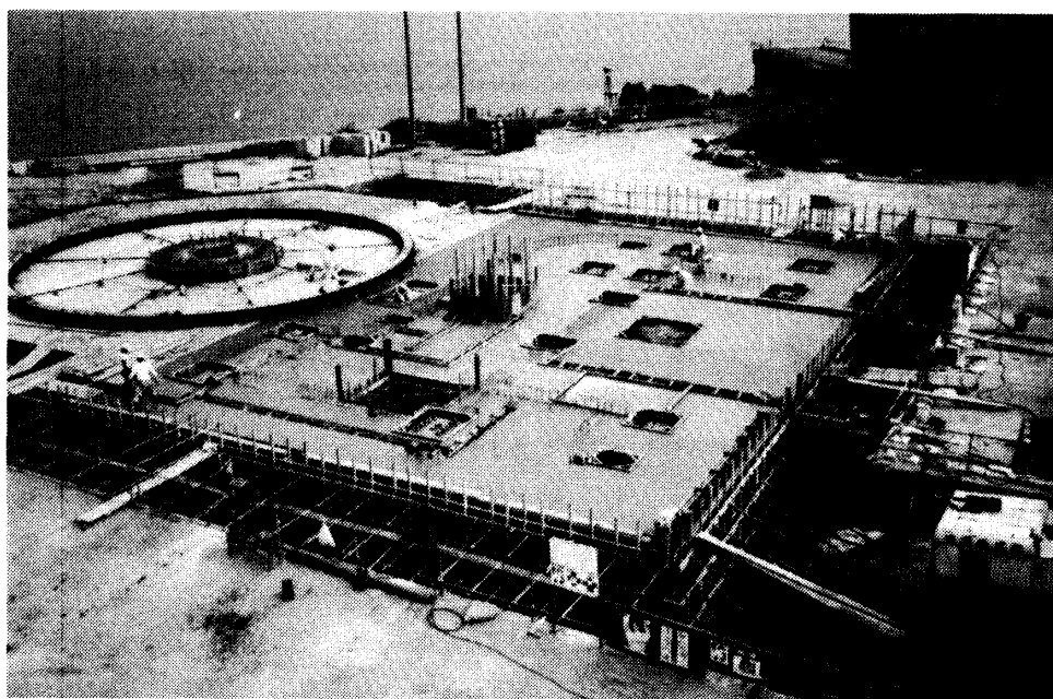
第28図 基礎工事完了状態
