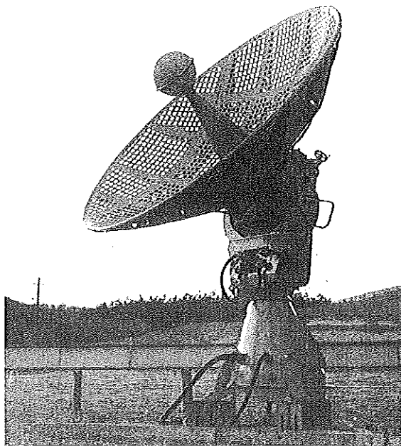
写真1 初代2 mレーダのパラボラアンテナ（生産研究, Vol. 9, No. 4, 1957年, 観測ロケット特集号の巻頭写真ページより）
