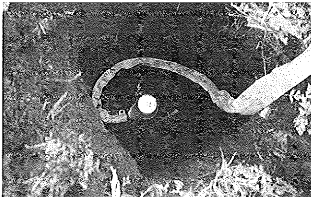
図3 地震計の埋設状況
