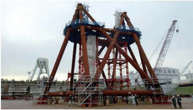
アンテナ AZ 回転構造部の仮組状況
