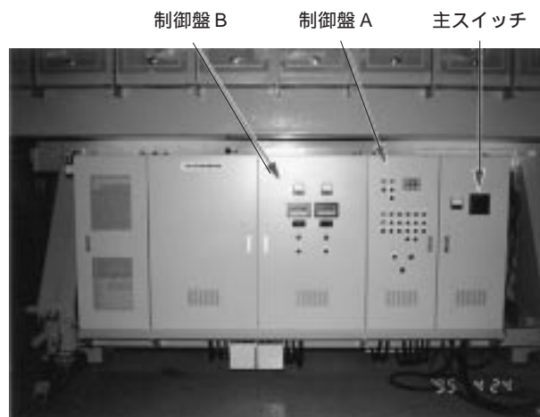
図 13 機側制御盤
