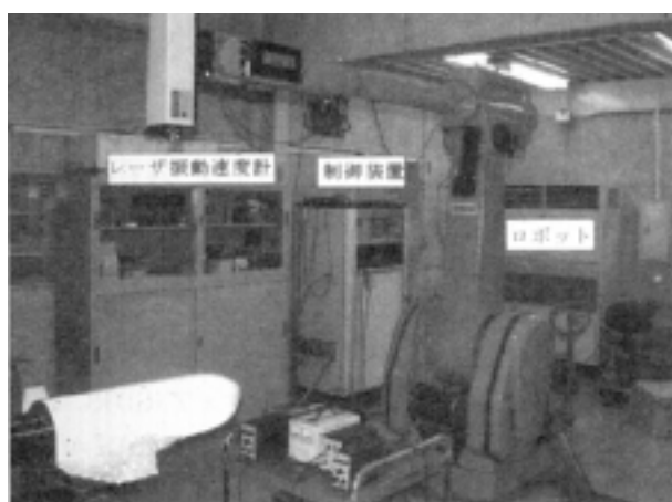
図 2-3 システム状況(ロボット周り)
