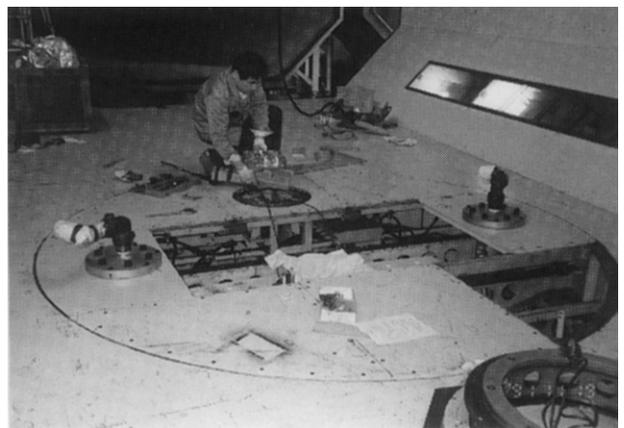
写真 A-8 ターンテーブルと圧力容器の取付状況
