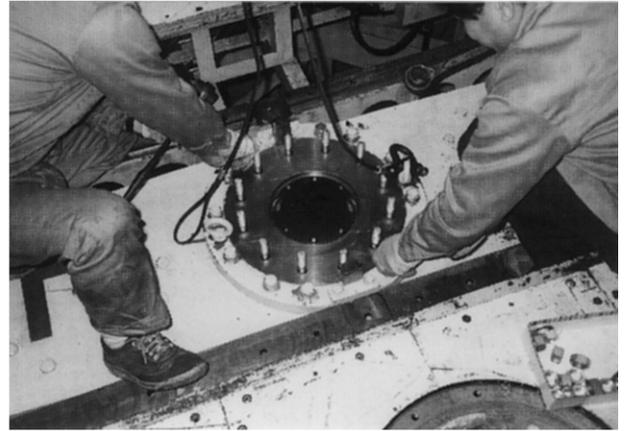
写真 A-15 支柱取付基盤と支柱取付台の組立作業
