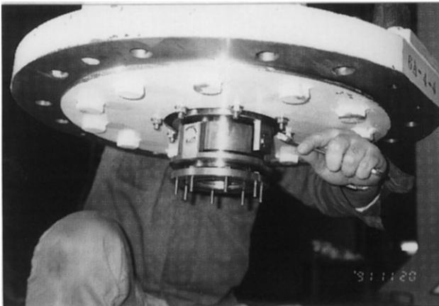
写真 A-13 ペローズ継手と支柱取付基盤の組立作業
