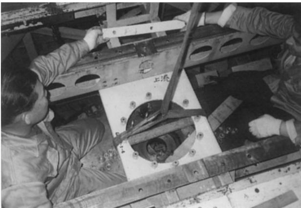
写真 A-1 継手本体取付基盤の取付作業
