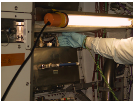
第 6 図 IVA 作業（操作する箇所に対し、容易に、障害なくアクセスできるかを確認する）
