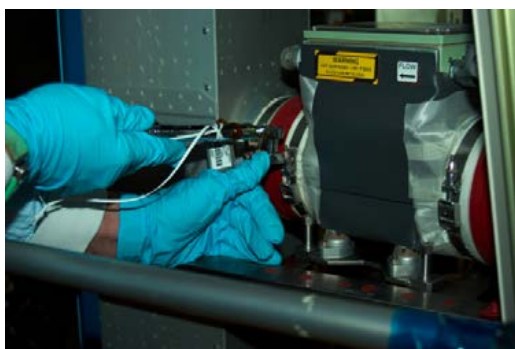
第 7 図 IVA 作業（使用する工具について、適切な工具が選択されているか、周囲と干渉することなく使用できるかなどを確認する）
