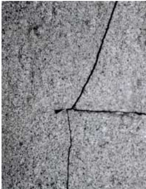
図2-10 SiC被膜の割れ発生状況
