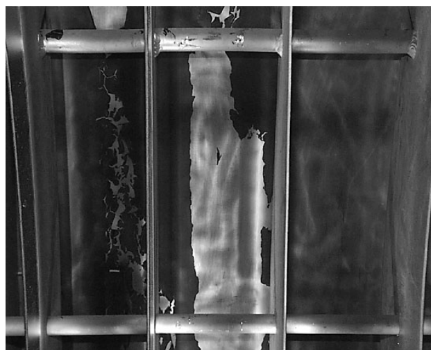
図5 クライオパネルの汚染状況
