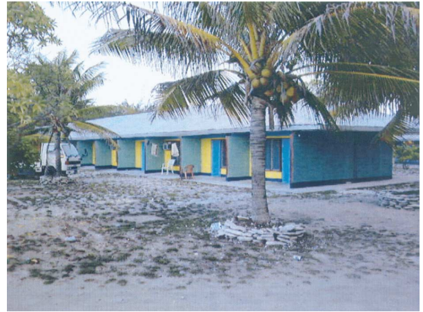
写真4.1.1 CCH(キャプテン・クック・ホテル) 外観
