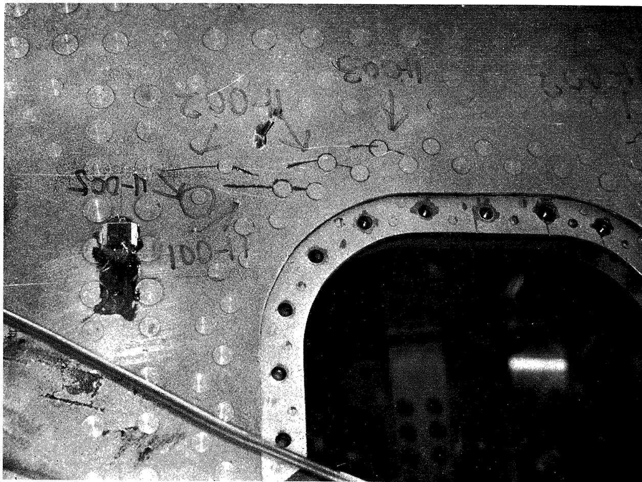
図 25 コレクタータンク近くのき裂
