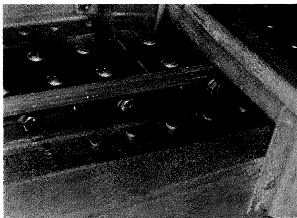
図 21 Saw cut のき裂の補強
