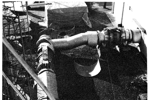
図 5 6 金属製伸縮継手 Exp5 及び Exp6 (右端) の開放検査
