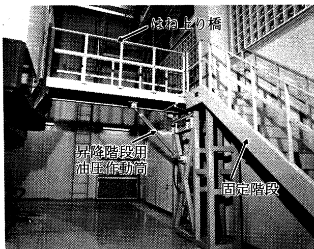
図11 昇降階段外観図
