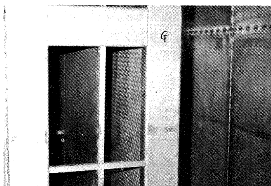
図14 第1・2変形スプリッター型消音器の内部
