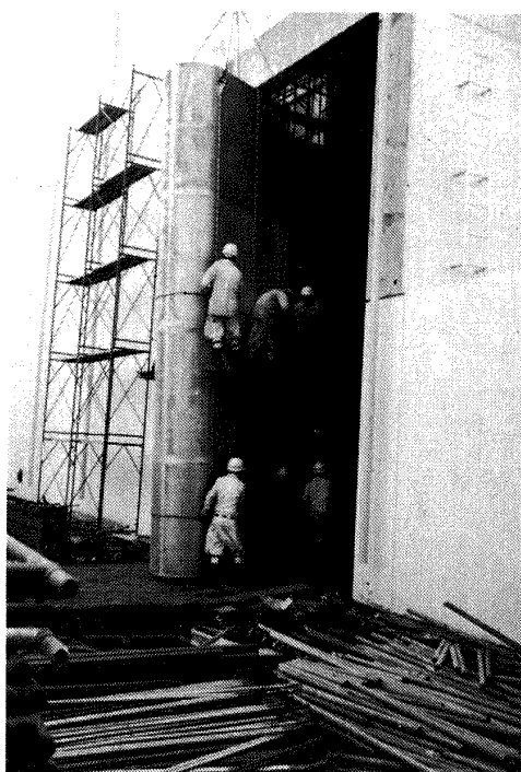
図13 第1変形スプリッター型消音器(前部)搬入状況
