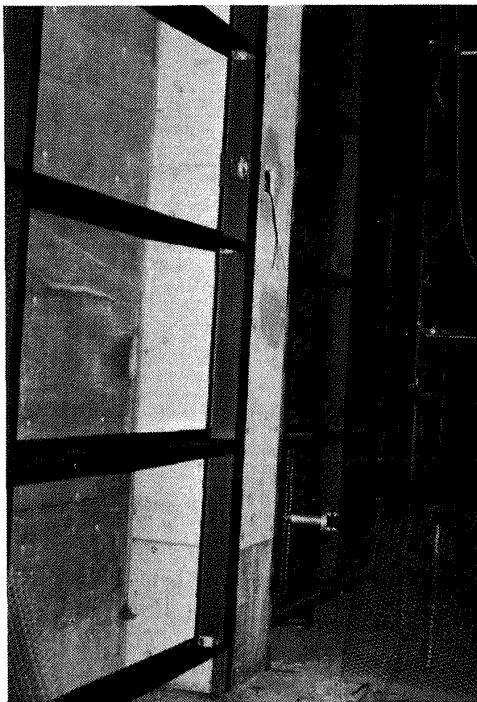
図10 背後空気層付吸音壁の取付状況
