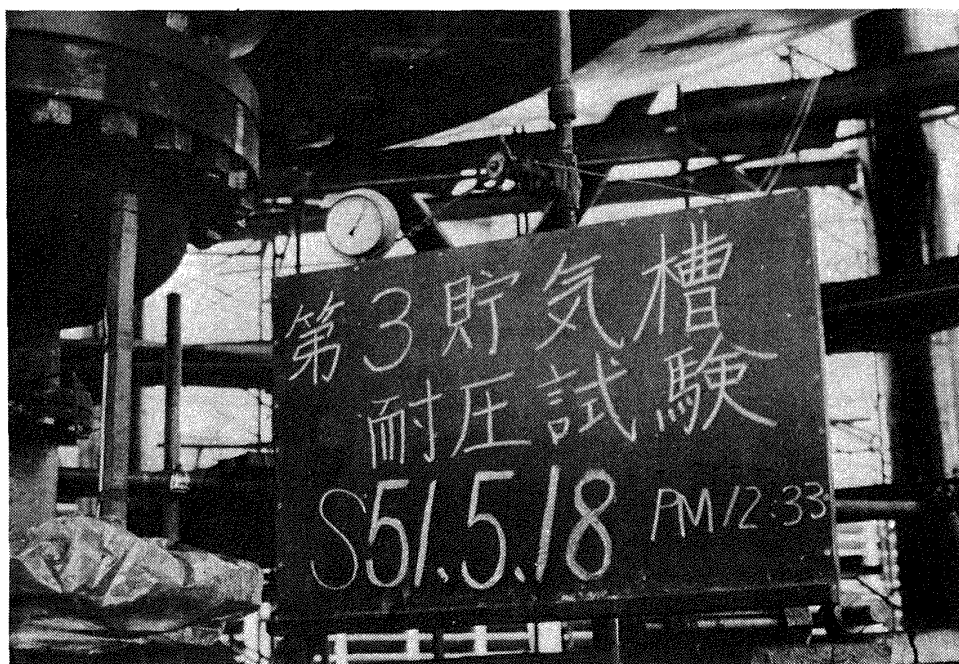
貯気槽下圧力計
