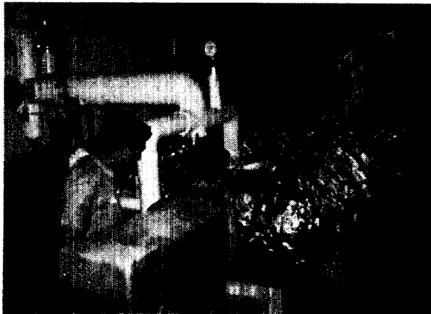
図 5.14 窒素ガス排気系配管断熱
