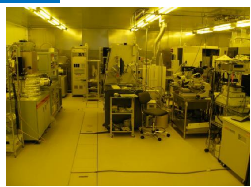
スーパークリーンルーム全貌
