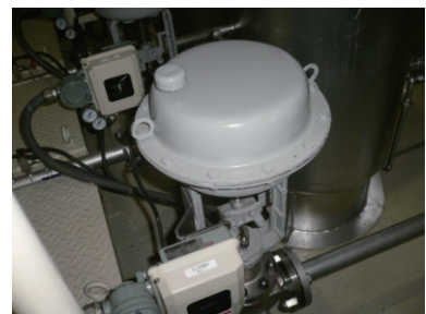
(c) 圧力制御弁
