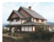
住宅への断熱材使用例
